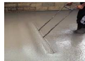
Figure 1 : Egalisation d'une chape après sa mise en place avec LC FLUID
