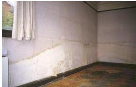
Les remontées capillaires font de nombreux dégâts dans les bâtiments jusqu'à 1 m à 1,50 m du sol :
